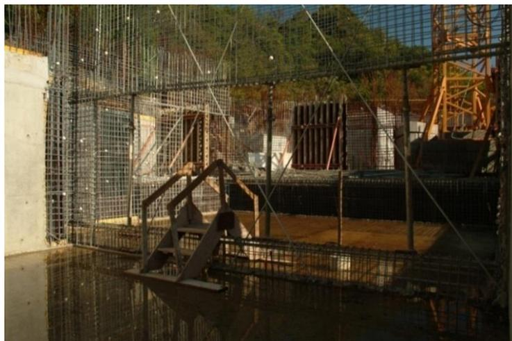
Figura 156 - Armação das paredes. Fonte: <http://mdc.arq.br/2010/12/07/fundacao-ibere-camargo-porto-alegre-rs>
