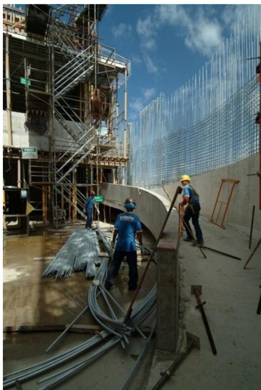
Figura 175 –. Execução da rampa interna. Fonte: <http://mdc.arq.br/2010/12/07/fundacao-ibere-camargo-porto-alegre-rs>
