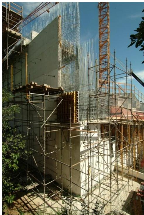
Figura 176 e Figura 177 – Vista da armadura das paredes em módulos de concretagem. Fonte: <http://mdc.arq.br/2010/12/07/fundacao-ibere-camargo-porto-alegre-rs>
