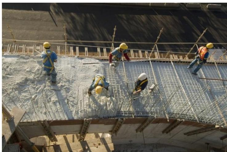
Figura 189 –. Concretagem de rampa. Fonte: <http://mdc.arq.br/2010/12/07/fundacao-ibere-camargo-porto-alegre-rs>
