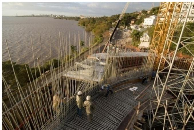
**Figura 191 – Armadura das paredes da rampa. Fonte: <http://mdc.arq.br/2010/12/07/fundacao-ibere-camargo-porto-alegre-rs>**
