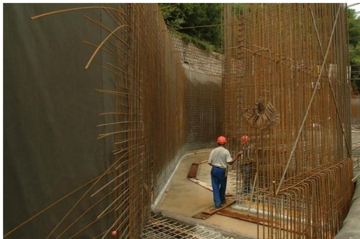
Figura 153 - Armação das paredes. Fonte: <http://mdc.arq.br/2010/12/07/fundacao-ibere-camargo-porto-alegre-rs>
