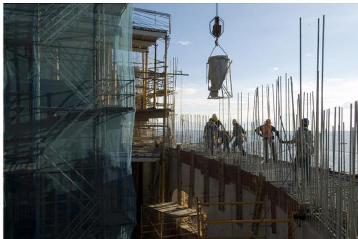
Figura 187 –. Armadura das rampas. Fonte: <http://mdc.arq.br/2010/12/07/fundacao-ibere-camargo-porto-alegre-rs>
