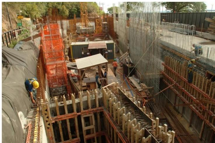
Figura 154 – Execução do Subsolo. Fonte: <http://mdc.arq.br/2010/12/07/fundacao-ibere-camargo-porto-alegre-rs>
