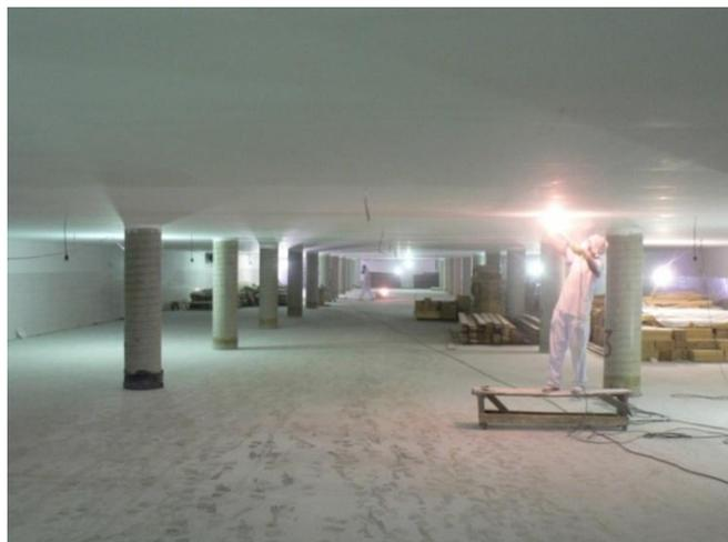
**Figura 216 - Em dezembro de 2007, foram realizadas a pintura e a lixação do forro do estacionamento. Fonte: <http://mdc.arq.br/2010/12/07/fundacao-ibere-camargo-porto-alegre-rs/#jp-carousel-3952>**
