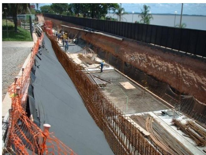
Figura 149 - Execução do subsolo. Fonte: <http://mdc.arq.br/2010/12/07/fundacao-ibere-camargo-porto-alegre-rs>
