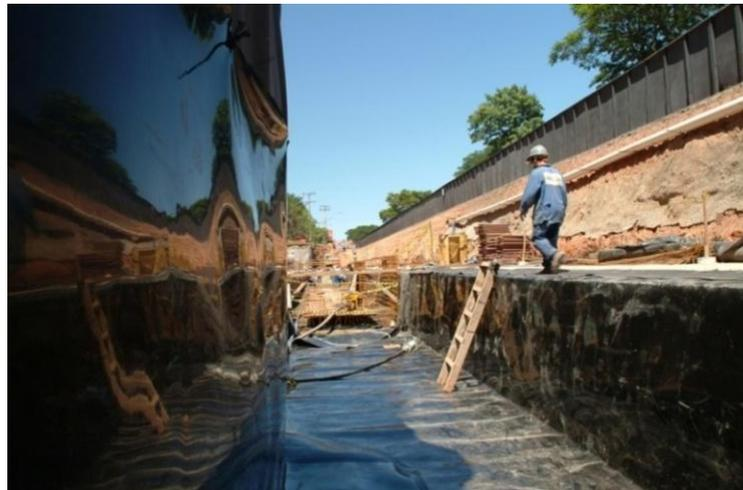
Figura 148 - Galeria técnica com manta de impermeabilização Fonte: <http://mdc.arq.br/2010/12/07/fundacao-ibere-camargo-porto-alegre-rs>
