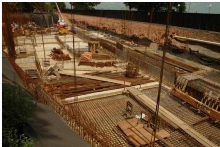
Figura 144 - Concretagem da laje de piso do edifício principal. Fonte: <http://mdc.arq.br/2010/12/07/fundacao-ibere-camargo-porto-alegre-rs>
