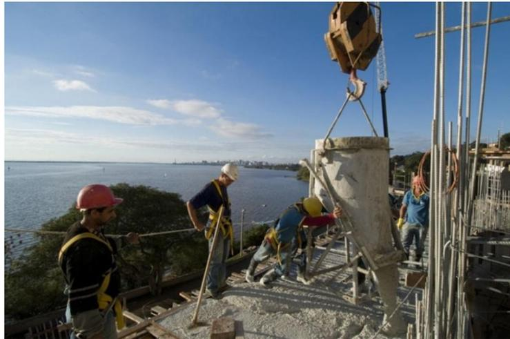
Figura 186 –. Concreagem da rampas externas. Fonte: <http://mdc.arq.br/2010/12/07/fundacao-ibere-camargo-porto-alegre-rs>
