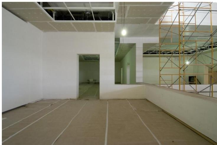
Figura 213 - Colocação de gesso nas salas de exposição Fonte: <http://mdc.arq.br/2010/12/07/fundacao-ibere-camargo-porto-alegre-rs>
