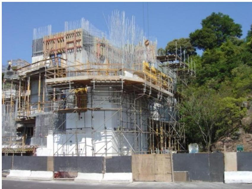
Figura 174 –. Escoramento das paredes externas. Fonte: <http://mdc.arq.br/2010/12/07/fundacao-ibere-camargo-porto-alegre-rs>
