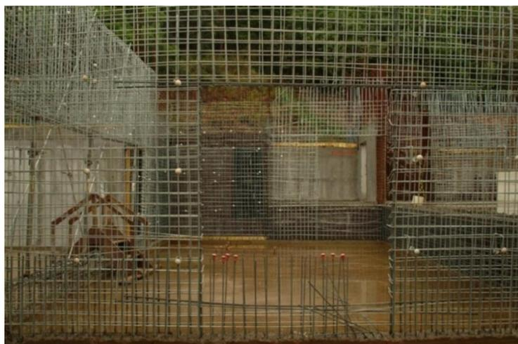
Figura 158 - Armação das paredes. Fonte: <http://mdc.arq.br/2010/12/07/fundacao-ibere-camargo-porto-alegre-rs>
