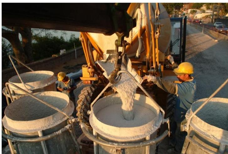
Figura 162 – Preparação do concreto branco. Fonte: <http://mdc.arq.br/2010/12/07/fundacao-ibere-camargo-porto-alegre-rs>
