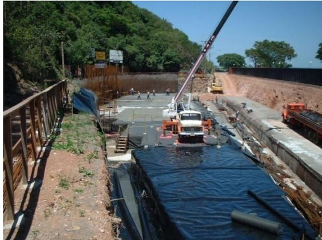
Figura 147 - Manta de impermeabilização Fonte: <http://mdc.arq.br/2010/12/07/fundacao-ibere-camargo-porto-alegre-rs>
