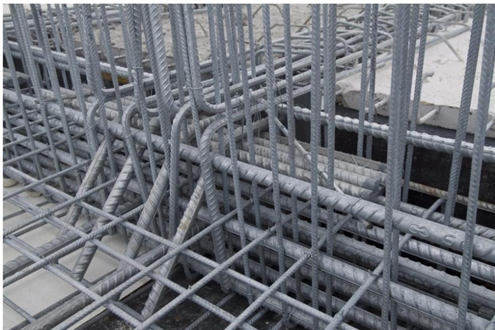
**Figura 195 – Armaduras de aço galvanizado. Fonte: <http://mdc.arq.br/2010/12/07/fundacao-ibere-camargo-porto-alegre-rs>**
