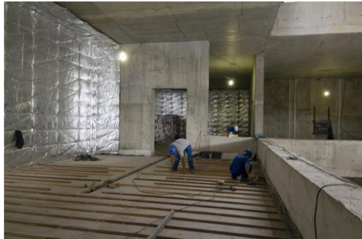
**Figura 212 - Revestimento de lã de rochanas salas de exposição.** Fonte: <http://mdc.arq.br/2010/12/07/fundacao-ibere-camargo-porto-alegre-rs>
