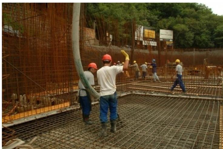
Figura 145 - Concretagem da laje de piso do edifício principal. Fonte: <http://mdc.arq.br/2010/12/07/fundacao-ibere-camargo-porto-alegre-rs>
