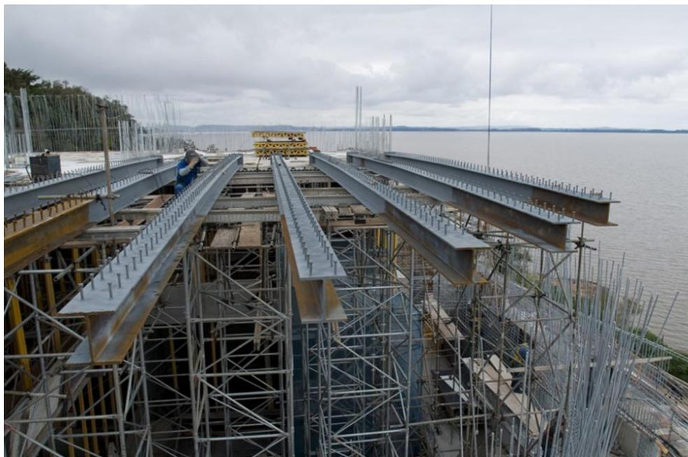
**Figura 194 – Posicionamento dos perfis metálicos. Fonte: <http://mdc.arq.br/2010/12/07/fundacao-ibere-camargo-porto-alegre-rs>**
