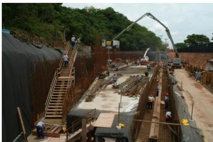
Figura 146 – Laje concretada. Fonte: <http://mdc.arq.br/2010/12/07/fundacao-ibere-camargo-porto-alegre-rs>
