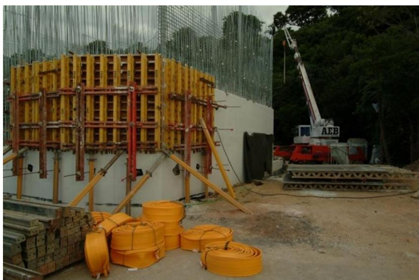
Figura 173 –. Escoramento das paredes externas. Fonte: <http://mdc.arq.br/2010/12/07/fundacao-ibere-camargo-porto-alegre-rs>
