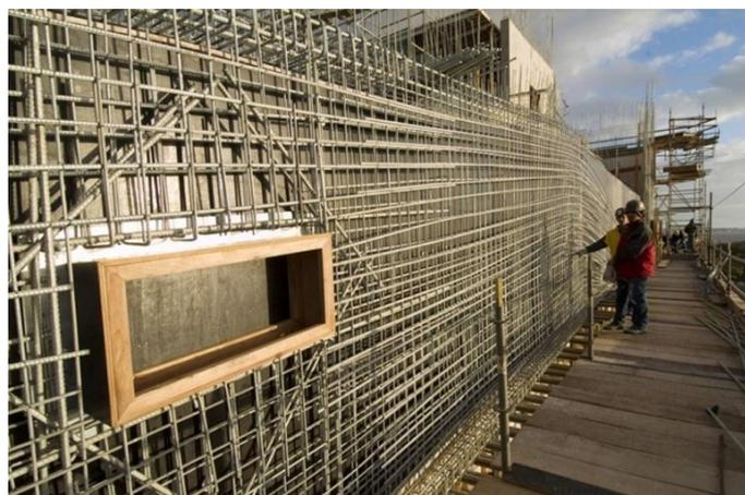
Figura 190 – Armadura das paredes das rampas exteriores e base da esquadria. Fonte: <http://mdc.arq.br/2010/12/07/fundacao-ibere-camargo-porto-alegre-rs>
