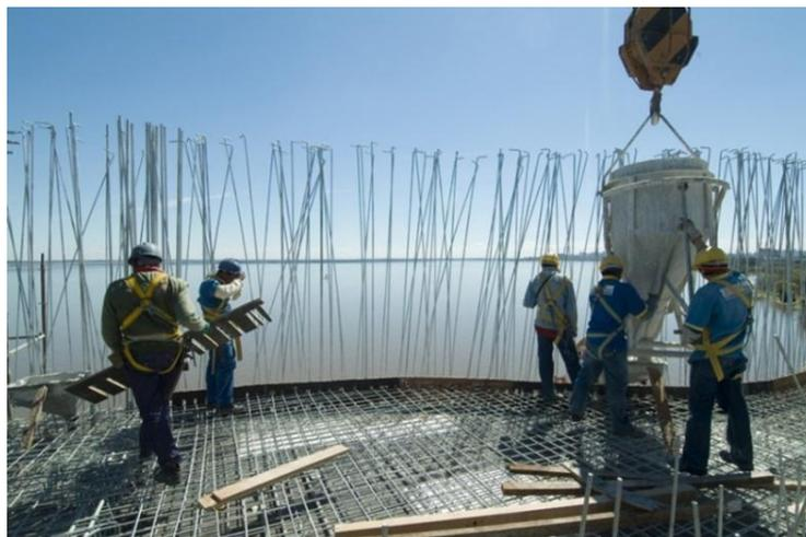
Figura 188 –. Concretagem de módulo de parede da fachada. Fonte: <http://mdc.arq.br/2010/12/07/fundacao-ibere-camargo-porto-alegre-rs>
