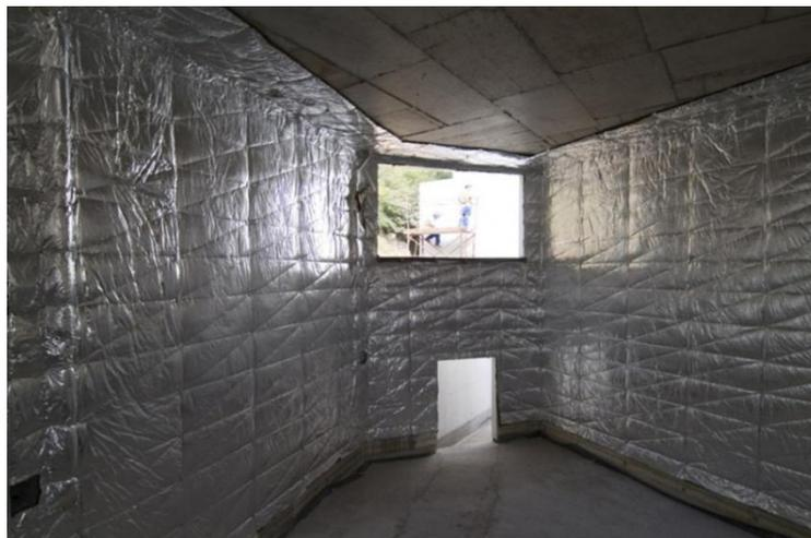
**Figura 211 - Revestimento das salas de exposição com lã-de-rocha** Fonte: <http://mdc.arq.br/2010/12/07/fundacao-ibere-camargo-porto-alegre-rs>
