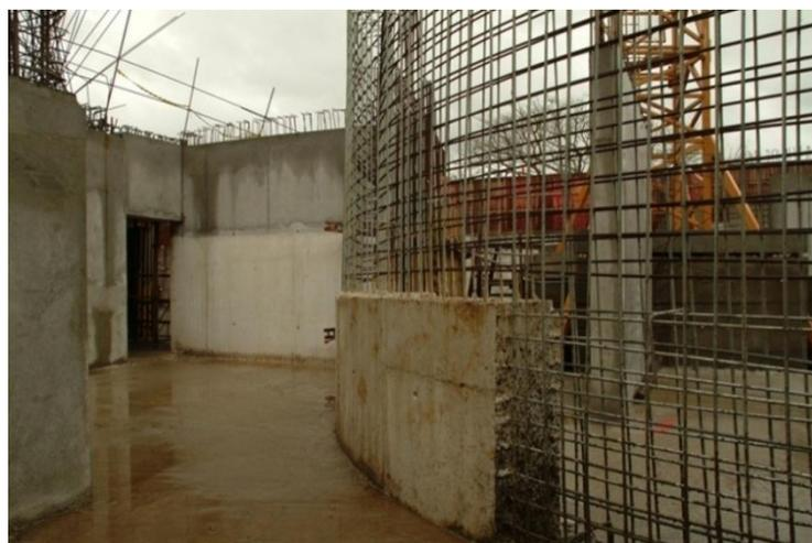
Figura 157 - Armação das paredes. Fonte: <http://mdc.arq.br/2010/12/07/fundacao-ibere-camargo-porto-alegre-rs>
