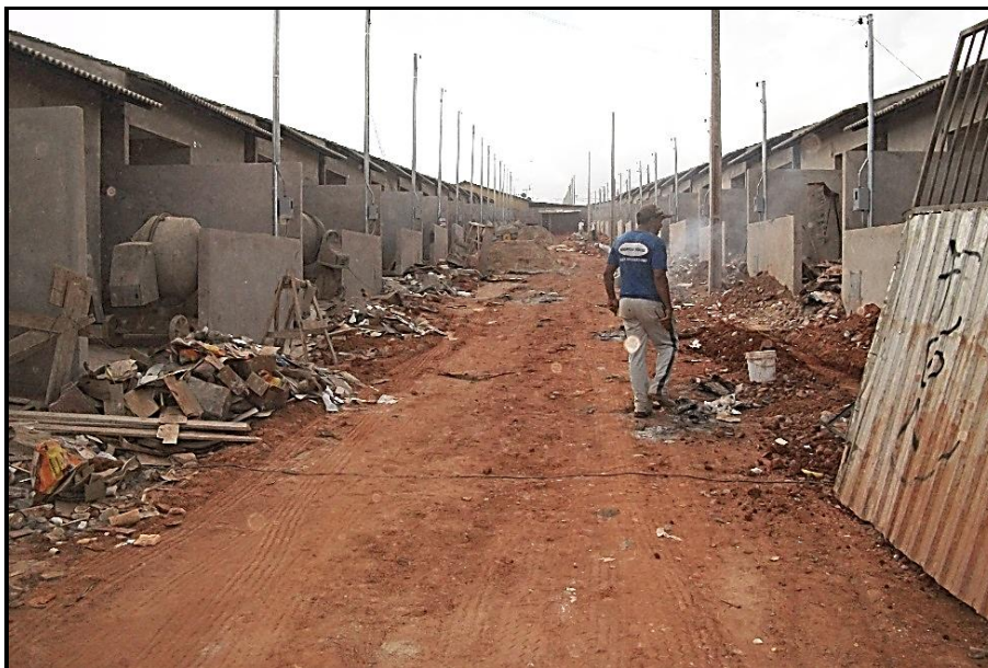
Figura 09- Condomínio em construção no Setor de Chácaras Anhanguera C em Valparaíso de Goiás/GO. Foto: Silva, Eliete Barbosa de Brito. 2013.
