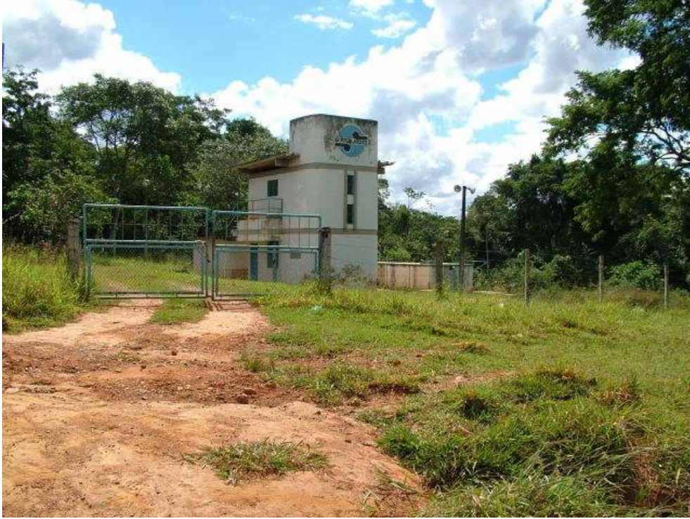
FIGURA 9 - Vista externa da estação de tratamento de água da SANEAGO em Goianópolis
