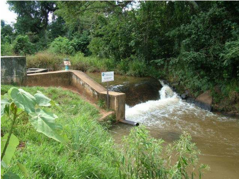
FIGURA 10 - Vista do ponto de coleta de água dentro da estação da SANEAGO
