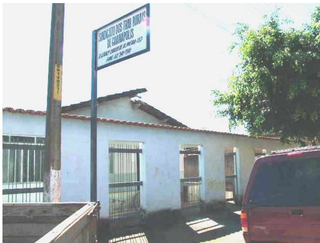
Figura 29 - Vista da fachada do Sindicato dos Trabalhadores Rurais de Goianópolis
