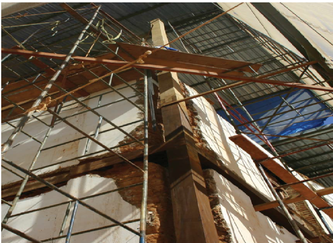
Imagem nº 12 - Durante o restauro, estabilização da estrutura da torre do sino - Fonte: UNES, 2008.
