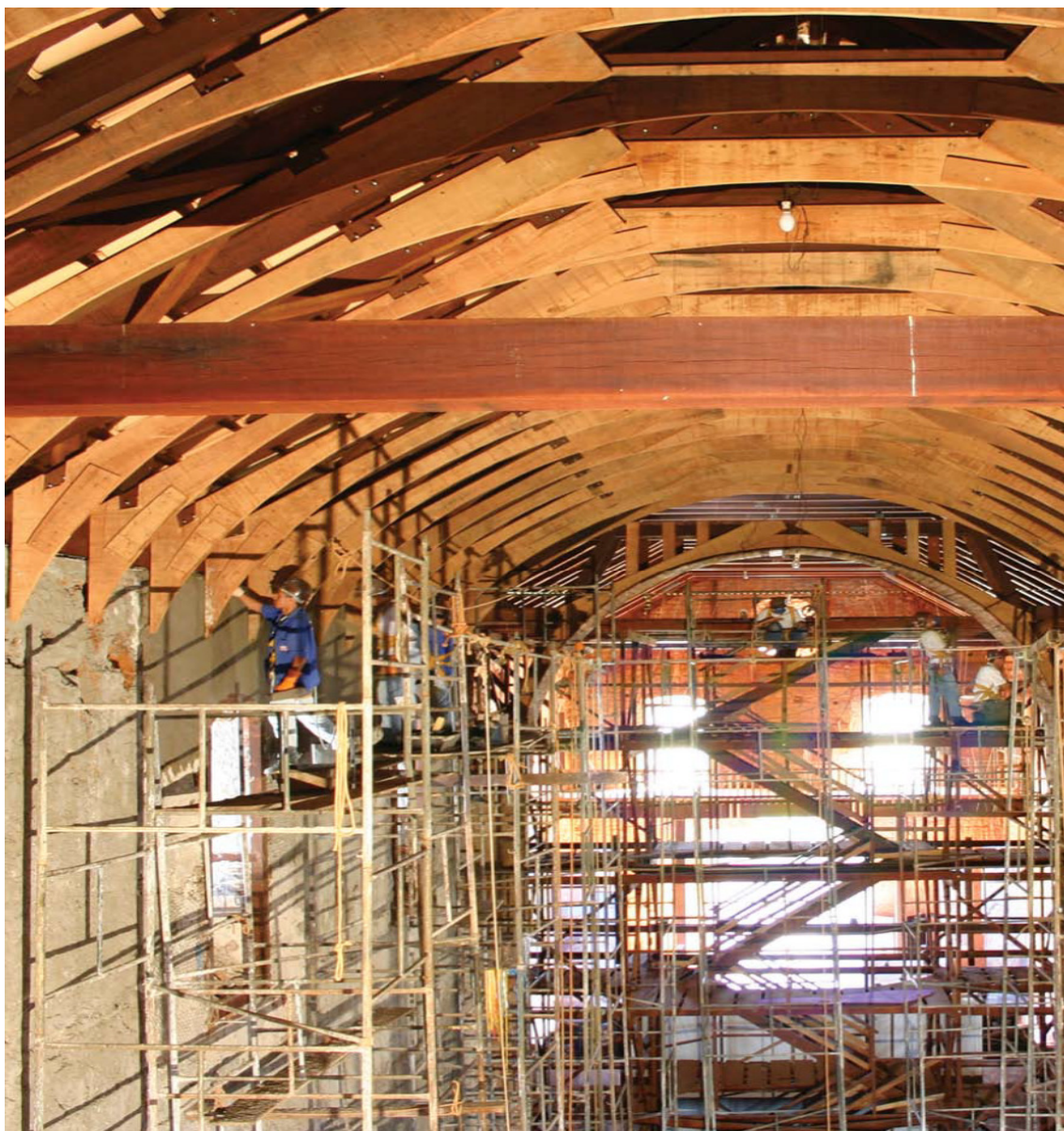
Imagem nº 14 - Trabalhos de restauro no telhado e no forro - Fonte UNES,2008.
