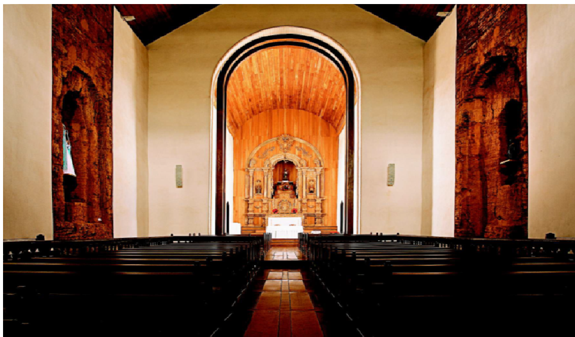
Imagem nº 16 - Vista do interior da Matriz após os trabalhos de restauro, onde se nota a opção de deixar a mostra vestígios do fogo no lugar dos nichos laterais - Fonte UNES,2008.
