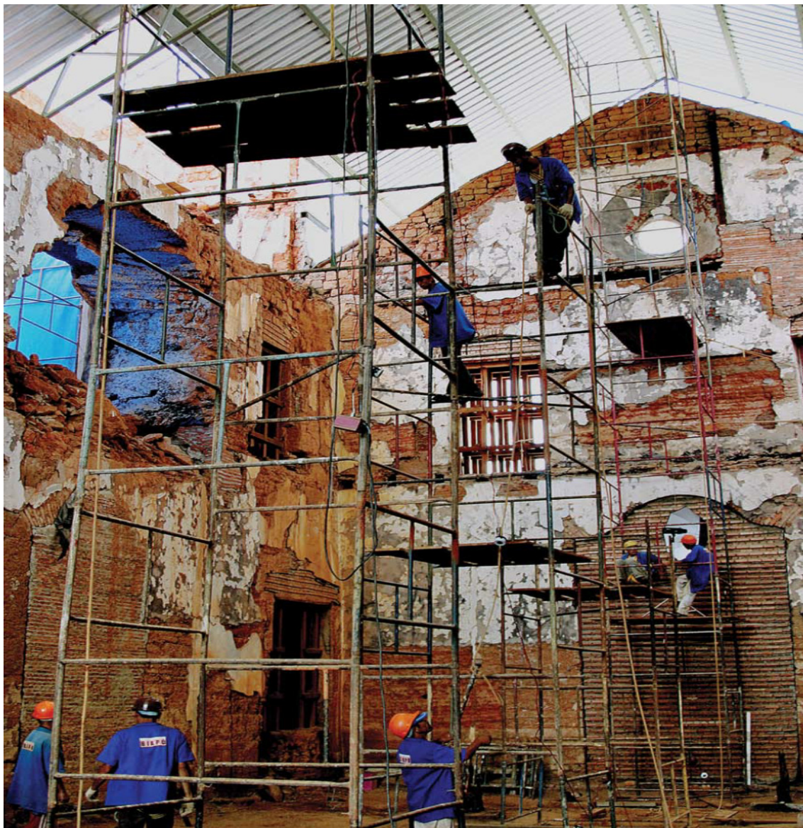
Imagem nº 13 - Processo de restauro em início - Fonte: UNES, 2008.
