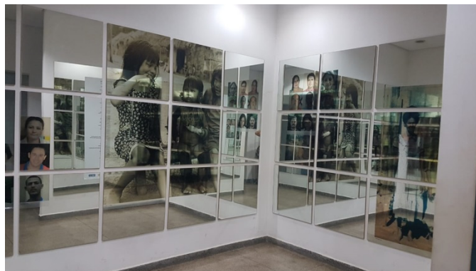
Imagem 38: Instalação espelhos. Arquivo da autora.
