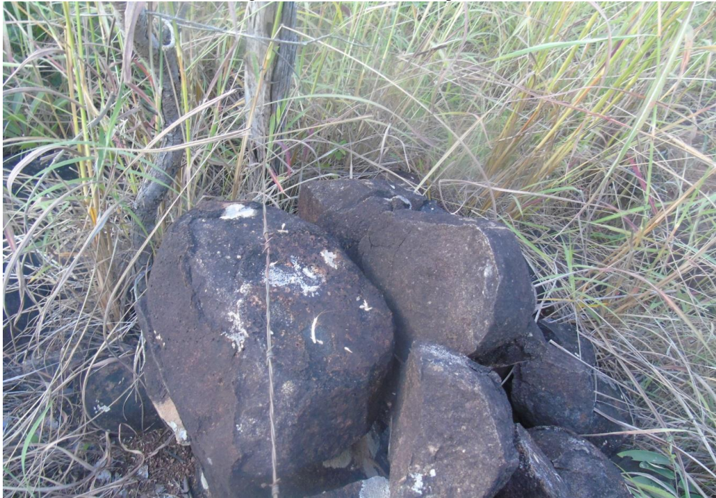
Figura 25: Final do muro de pedra
