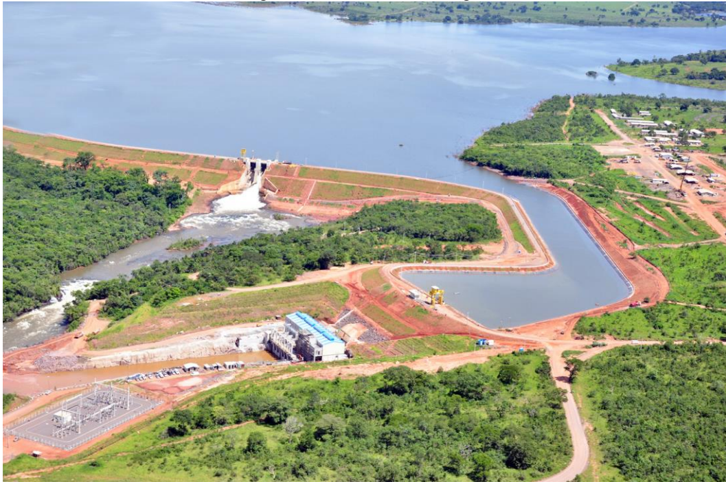
Figura 2: UHE de São Domingos
