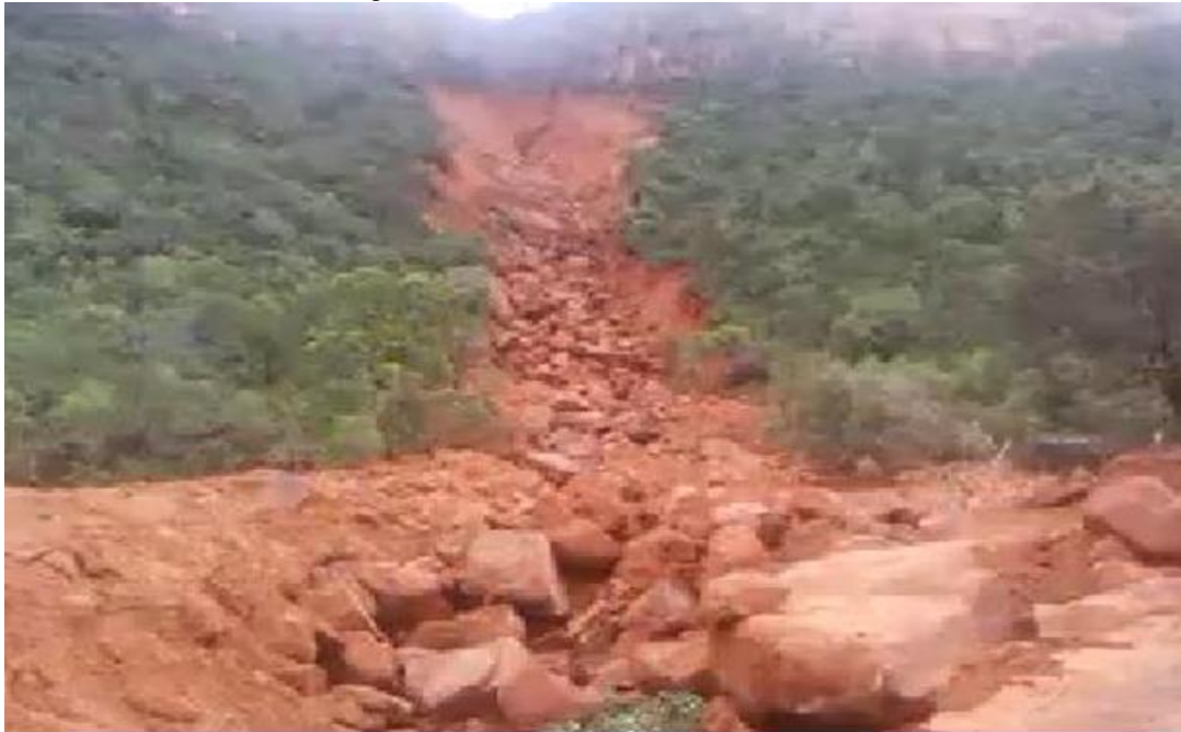
Figura 4: Erosão da encosta da Serra Geral
