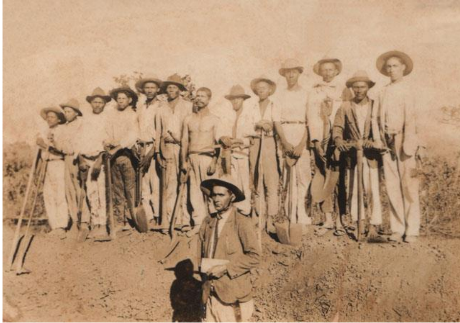
Figura 3: Trabalhadores Ferroviários na Construção da Estação Ferroviária de Anápolis. Fonte: Acervo do Museu Histórico de Anápolis.
