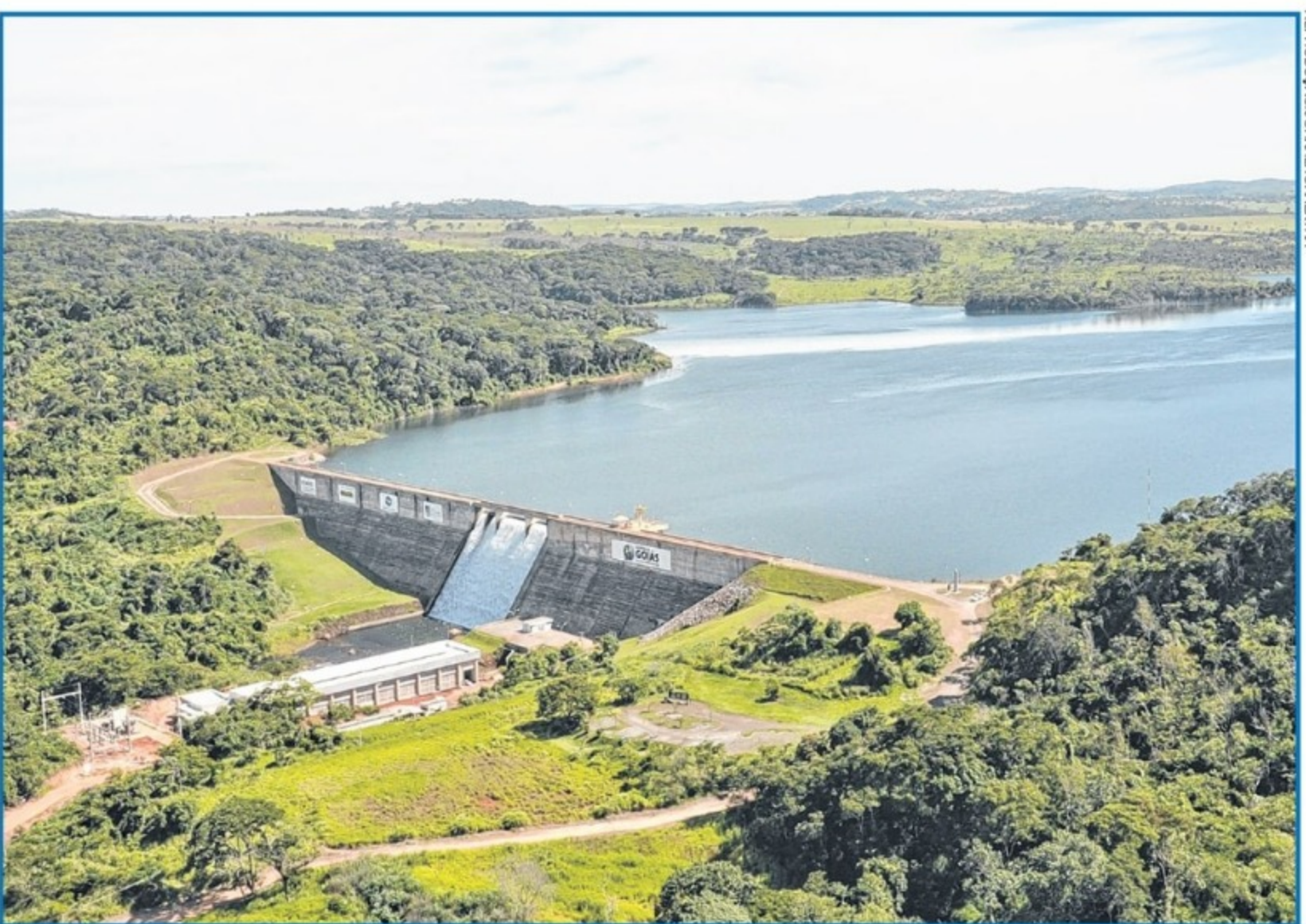
Goiânia padece por falta das interligações do sistema de saneamento: centro de cloração da água não estava pronto, então foi improvisado um centro de cloração nos próprios tanques
