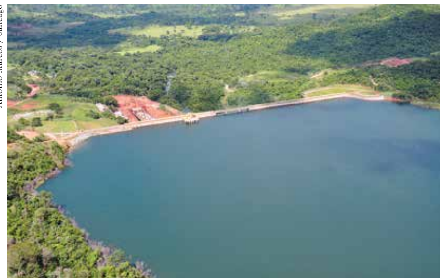
Vista parcial do reservatório da barragem João Leite
