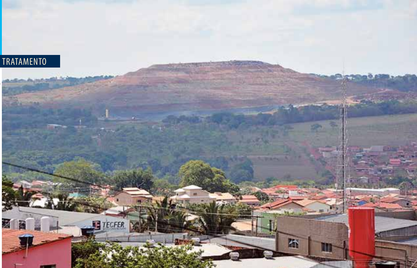
Vista do Aterro Sanitário de Goiânia localizado na saída para Trindade (GO - 060)
